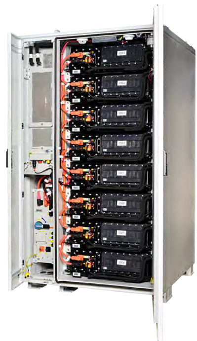
▣ Innenleben eines mit CATL- oder Sunsys-zellenbestückten Energiespeichers.
